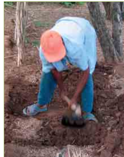
Escavação da fossa (continuação)
