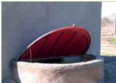
Proteção de um poço, Marrocos
