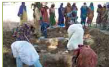
Escavação das fossas para compostagem, Níger
