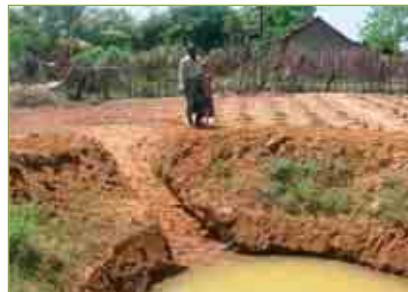
Cacimba em construção, Sri Lanka
