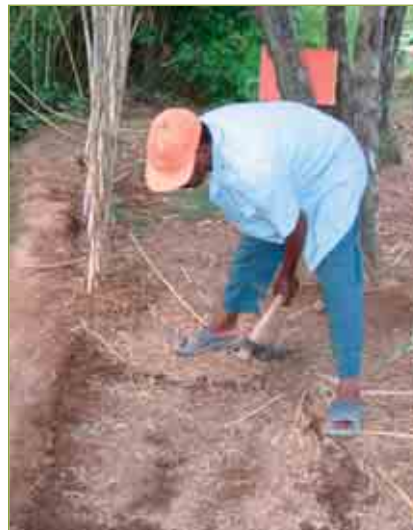
Etapa 1: Escavação da fossa
