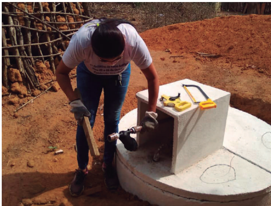
Técnica fazendo a montagem do motorbomba em cima do tanque de reúso para o sistema de irrigação.
